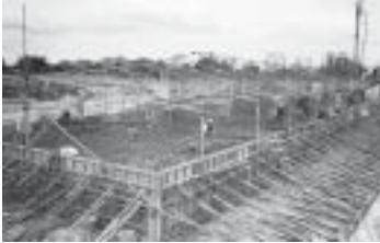
รูปที่ 4-9 ปูนซีเมนต์ปอร์ตแลนด์ดัดแปลง เหมาะสำหรับงานโครงสร้างที่ต้องสัมผัสกับดินหรือน้ำที่มีซัลเฟตปานกลาง หรือโครงสร้างที่มีความหนามาก เช่น ฐานรากขนาดใหญ่
