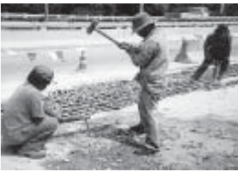
รูปที่ 4-37 ปูนซีเมนต์แข็งตัวเร็ว เหมาะสำหรับงานซ่อมแซมถนน
