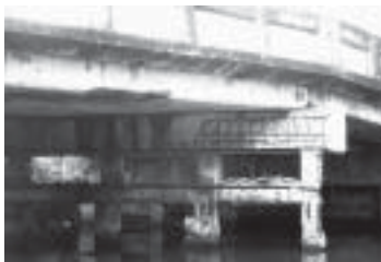
ข) ตัวอย่างความเสียหายของโครงสร้างในน้ำกร่อย
