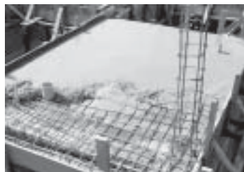
ค) งานเทคอนกรีตโครงสร้างขนาดเล็ก
