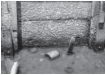
รูปที่ 4-14 ผิวคอนกรีตเสียหายเนื่องจากการกระทำของซัลเฟต
