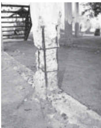
ค) ตัวอย่างความเสียหายของโครงสร้างในพื้นที่ดินเค็ม
