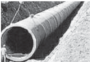
ค) โครงสร้างใต้ดินที่สัมผัสดินที่มีซัลเฟตสูง 7
