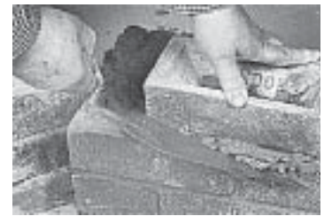
รูปที่ 4-21 Slag Cement สามารถนำมาใช้ในงานก่ออิฐผนังได้
