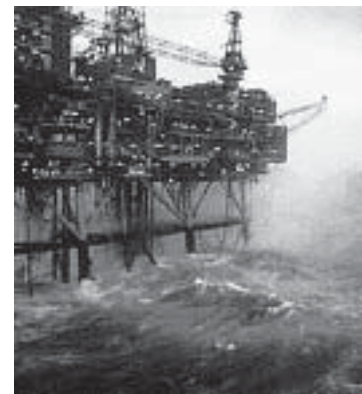
รูปที่ 4-30 งานขุดเจาะน้ำมัน
