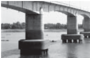
ข) โครงสร้างสะพานที่สัมผัสน้ำที่มีซัลเฟตสูง
