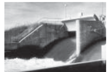
รูปที่ 4-12 ปูนซีเมนต์พอร์ตแลนด์ ประเภทเกิดความร้อนต่ำ เหมาะสำหรับงานคอนกรีตมวล เช่น เขื่อน เป็นต้น
