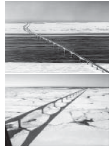
รูปที่ 4-16 ปูนซีเมนต์ปอร์ตแลนด์ประเภทกระจายกักฟองอากาศ เหมาะสำหรับงานโครงสร้างในสภาพภูมิอากาศหนาวเย็น เช่น สะพานข้ามทะเลที่มีแผ่นน้ำแข็งไหลผ่าน 8
