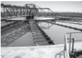
ก) บ่อบำบัดน้ำเสีย
